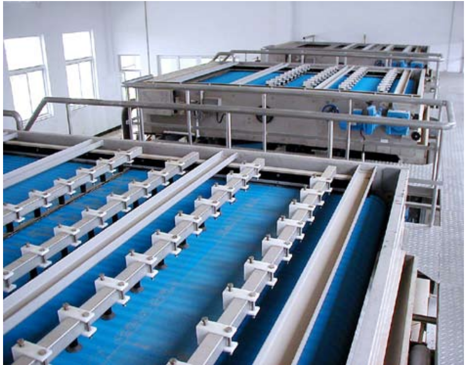
Einsatzbeispiel 1: Maschinelle Eindickung mit 3 Bandeindickern BGT 2000 auf einer Kläranlage in China.
