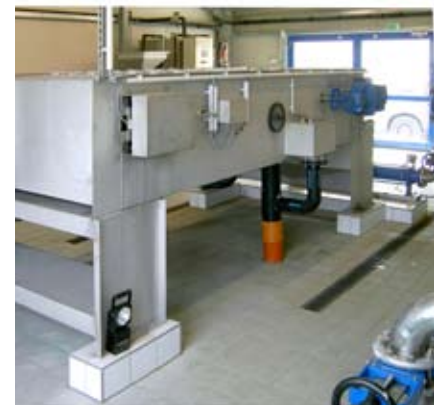
Einsatzbeispiel 4: Installation eines BGT 1000 auf einer Kläranlage in Hessen.
