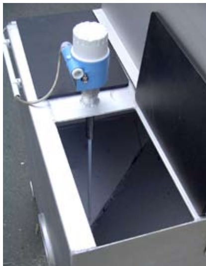
Störungsfreier Betrieb – Verschmutzungsunempfindliche Niveaumessung im Dickschlammkasten.
