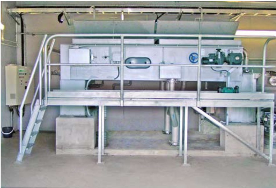
Aufstellung eines Bandeindickers BGT 1000 in Neuseeland
