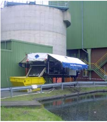
Einsatz unserer mobilen Versuchsanlage in einem Kraftwerk
