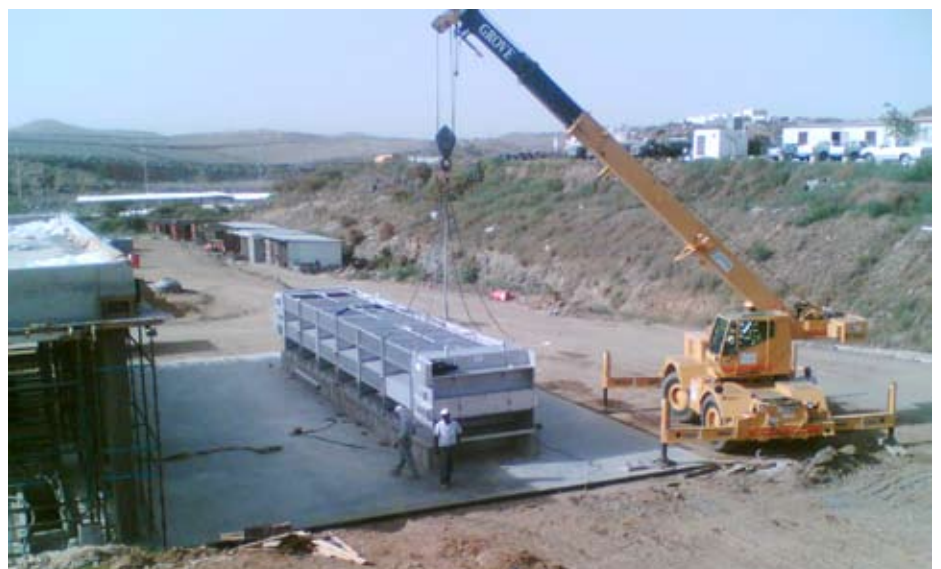
Montage eines Trockners
