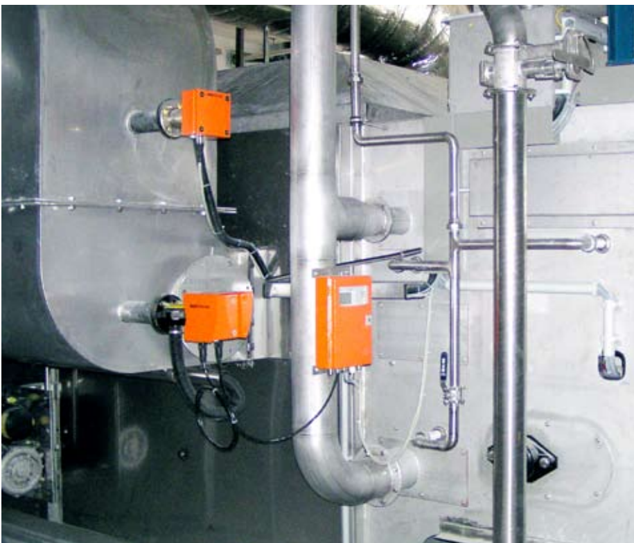
Erfüllung der ATEX-Vorschriften durch entsprechende Sicherheits- und Messtechnik
