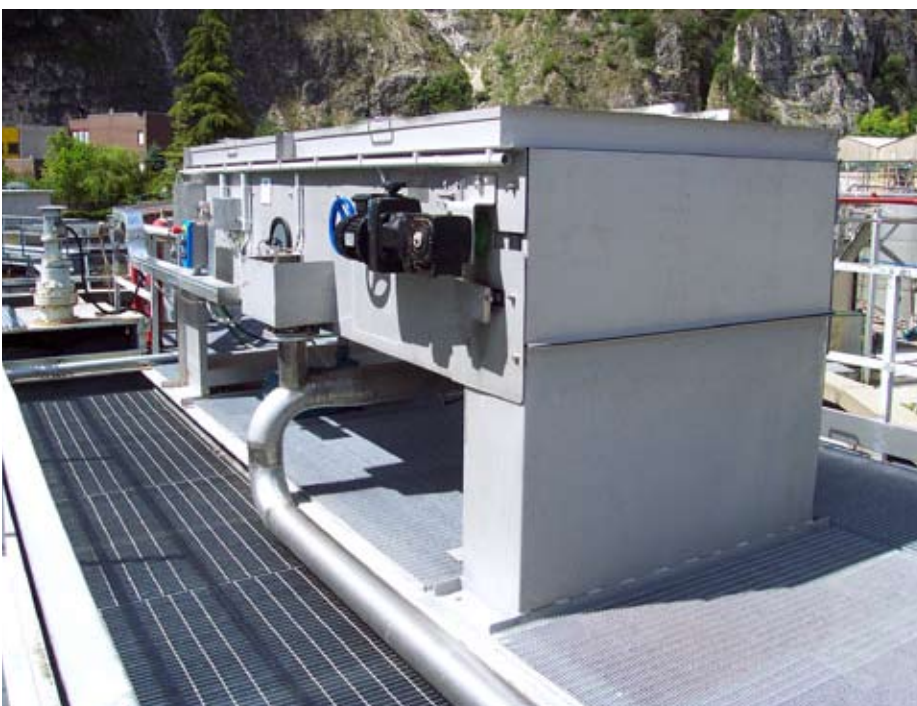
Außenanstellung eines BGT 1000 in gekapselter Ausführung in Norditalien
