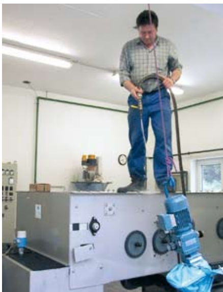
Installation eines Bandeindickers
